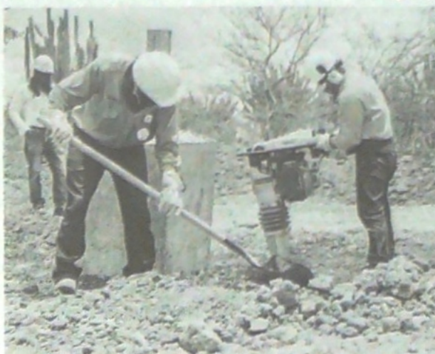
Operarios en los trabajos de refuerzo eléctrico.
