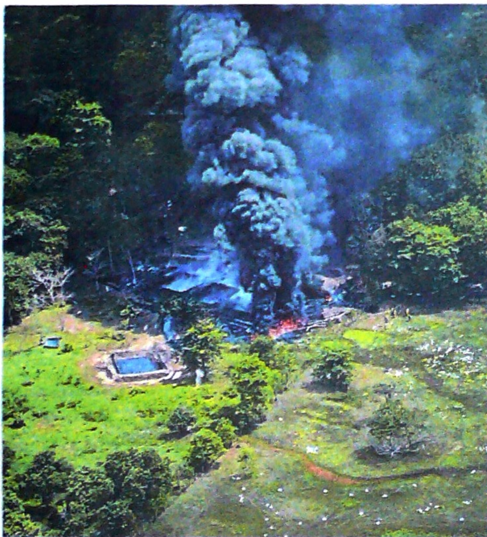
Incendio de piscinas de petróleo ayer en Arauca. FOTO. CORTESÍA ECOPETROL
