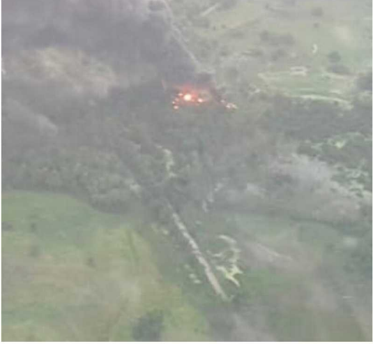
Incendio en una de las piscinas con petróleo / Ecopetrol
