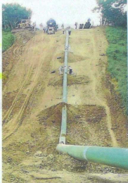
El nuevo gasoducto Jobo-Majaguas. // CORTESÍA
