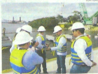
Técnicos de Surtigas en la zona de la afectación.
