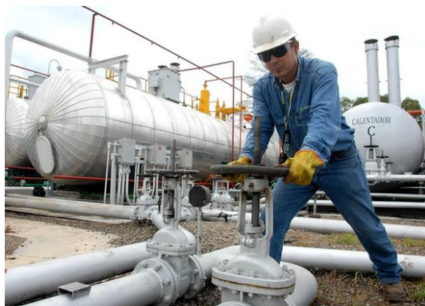
Blu Radio/ Trabajos ecopetrol. Foto: Facebook Ecopetrol
