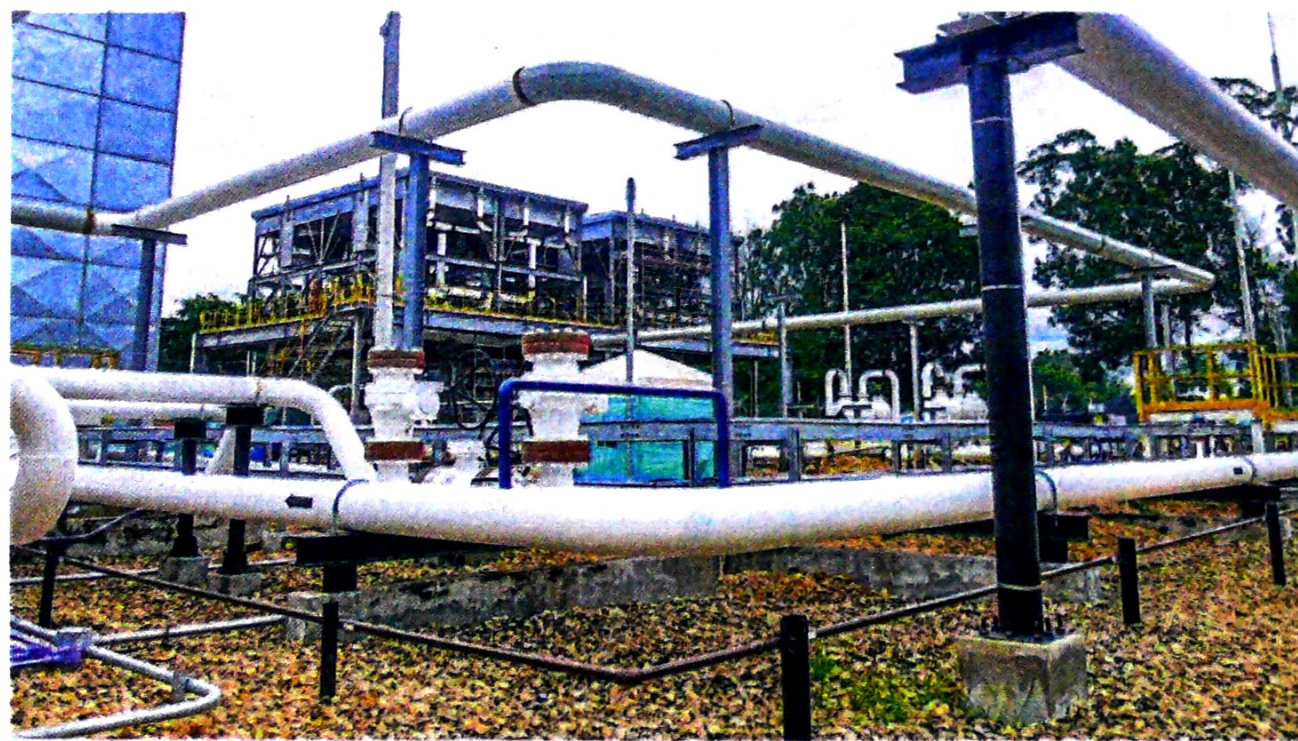
La obra consta de una línea de 85 Km de longitud y 20 pulgadas de diámetro. Además de una estación compresora. Promigas
