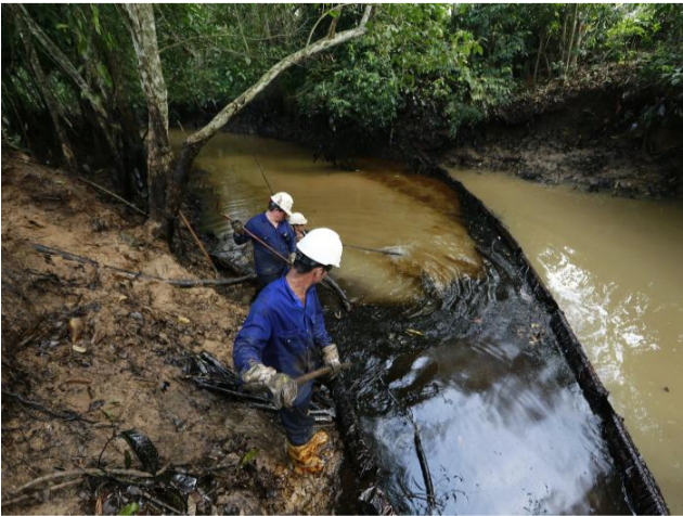
Este ataque produjo rotura del ducto y derrame de crudo en las quebradas La Petra y los ríos Margua y Arauca. JAIME MORENO - CEET
