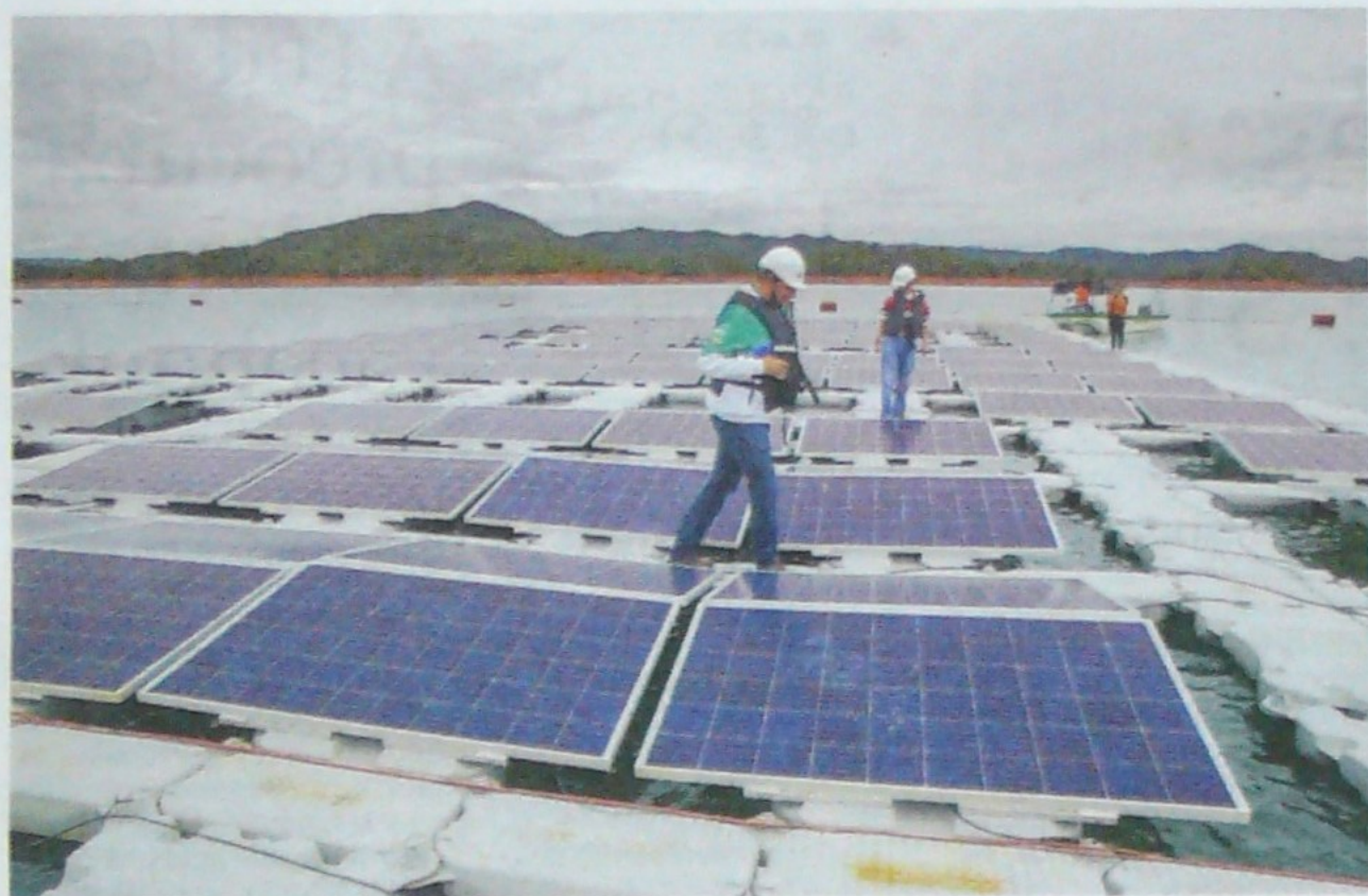
En el embalse El Peñol-Guatapé, ubicado en el Oriente antioqueño, EPM experimenta desde el año pasado con el primer parque solar flotante construido en Hispanoamérica. FOTO ESTEBAN VANEGAS
