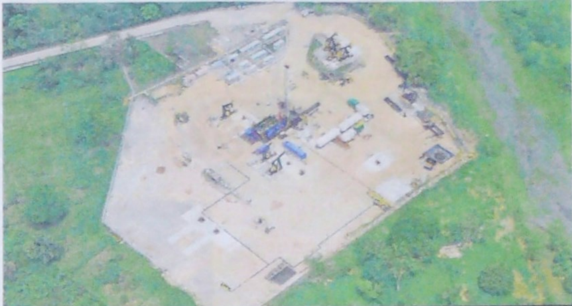
Campo petrolero de Ecopetrol Cantagallo - Yariguí.
