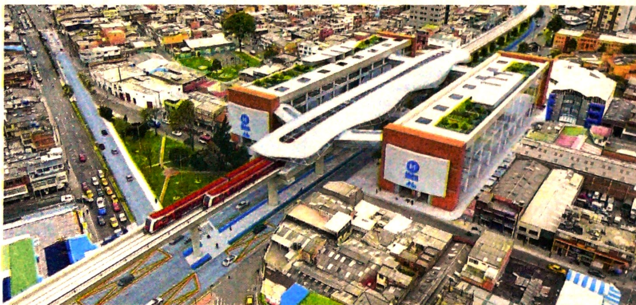
El pasado 28 de junio se abrió oficialmente la licitación del Metro con seis consorcios precalificados. Cortesía: Empresa Metro de Bogotá.
