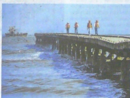
Cuatro ingenieros caminan sobre la parte a demoler.
