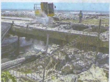
Un taladro rompe la placa del muelle de Puerto.
