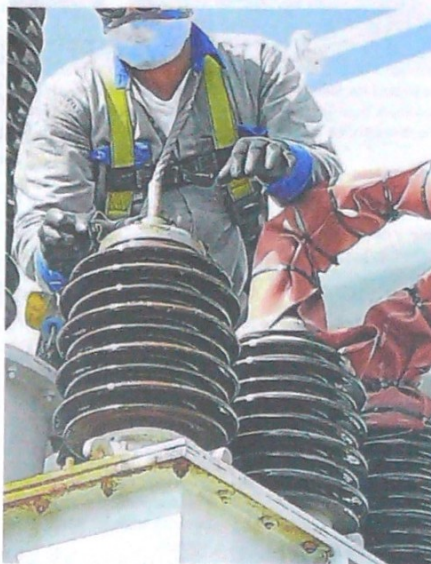
Mantenimiento eléctrico. // CORTESÍA
